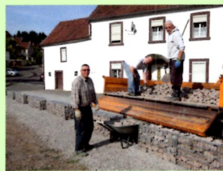
Erstellen von Gabionen am Berndt'schen Gelände
