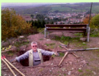
Am Wackepickerblick wurden eine Ruhebänk und ein Fahnenmast aufgestellt
