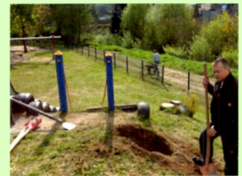
Ausschachtarbeiten am Kinderspielplatz zur Montage eines Sonnensegels
