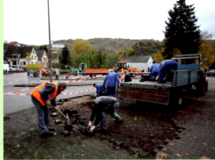
Erste Arbeiten 2013: Rückbau der alten Pflastersteine
