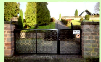
Renovierungsarbeiten an der alten Leichenhalle und an sämtlichen Zugangstoren zum Friedhof, Leistung eines Einzelnen!
